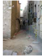
DSCN1582 Finalització primer tram rasa
