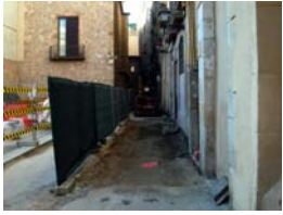
DSCN2082 Rebaix mecànic
