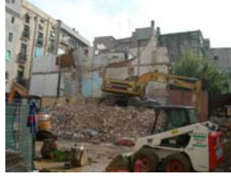
DSCN1725 Demolició mecànica
