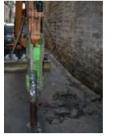
DSCN1335 Afectació asfalt
