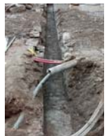
PIC02511 Afectació col·lector
