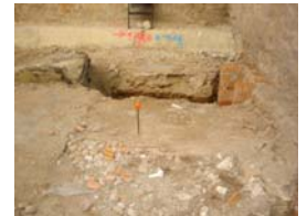
PIC02515 Construcció nous respiralls
