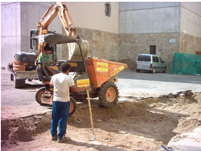
Vista del procés d'obertura de la rasa per accedir a la excavació del bunker
