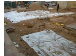
DSCN1580 protecció restes amb geotextil
