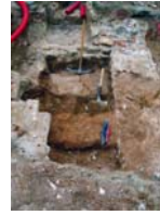
DSCN2093 Esc 3 Vista general procés excavació
