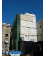
DSCN1464 Inici demolició
