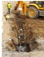
PIC02545 Afectació col·lector 2060
