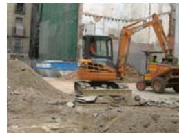
DSCN1440 Rebaix mecànic Sector 2
