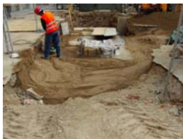
PIC02594 Construcció bunker
