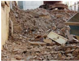
PIC02505 Demolició mecànica
