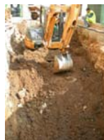
DSCN1655 Rebaix bunker
