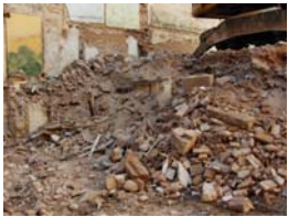
PIC02504 Demolició mecànica
