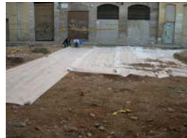
DSCN1578 Protecció restes amb geotextil
