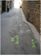
DSCN1309 Vista del tram a excavar
