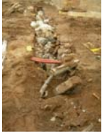
DSCN1726 Afectació col·lector
