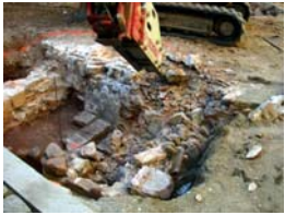
DSCN2189 Esc 6 Afectació
