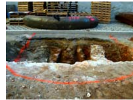
DSCN2186 Esc 6 Afectació
