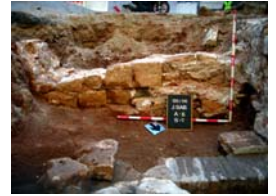
DSCN2129 Esc 6 Alçat mur u.e. 3022
