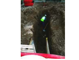
DSCN2066 Rasa connexió bunker
