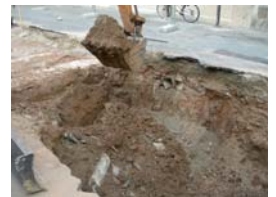
DSCN1281 Rebaix bunker
