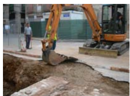
DSCN1307 Delimitació de les estructures
