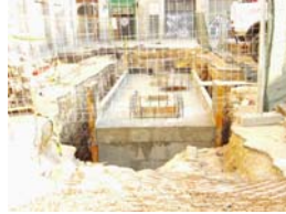
PIC02532 Construcció bunker
