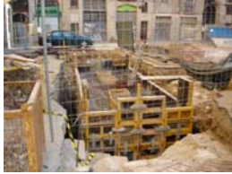
PIC02531 Construcció bunker
