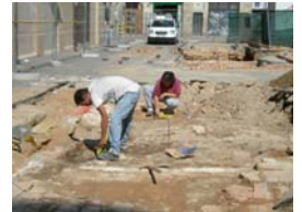
DSCN1414 Neteja manual estructures
