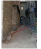
DSCN1583 Finalització primer tram rasa
