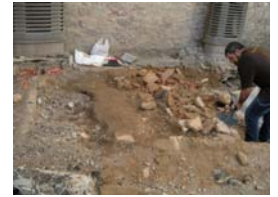
DSCN1584 Afectació paviment u.e. 2005
