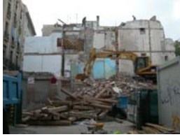
DSCN1656 Demolició mecànica
