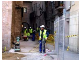
DSCN2032 Tasques pavimentació
