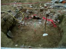
DSCN2119 Esc 5 procés excavació
