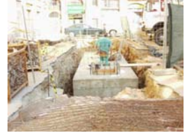
PIC02543 Construcció bunker
