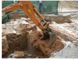
DSCN1640 Afectació estructures
