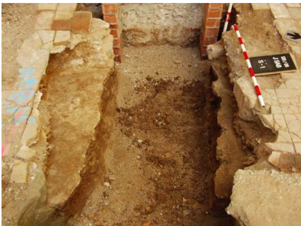
Vista de les restes del fons del dipòsit (u.e. 2075) afectat per l'obra
