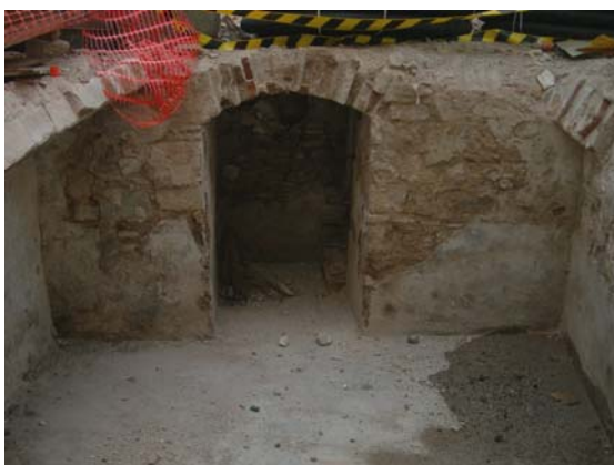
Imatges on s'aprecia les restes del soterrani amb la seva porta d'accés, el seu fons de ciment i les restes de la volta de maons
