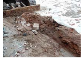
PIC02502 Afectació a Sector 2
