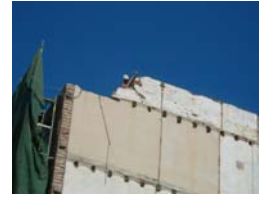
DSCN1466 Demolició manual
