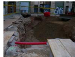
DSCN2071 Final tasques rasa connexió bunker
