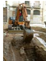
DSCN1614 Afectació arquetes modernes
