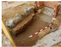
PIC02556 Construcció nou respirall
