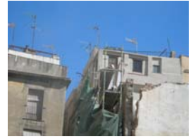
DSCN1563 Demolició manual
