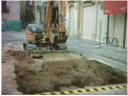
DSCN1251 Rebaix zona bunker
