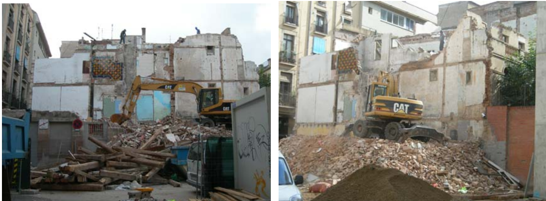
Desenrunament de l'edificació amb màquina giratòria
