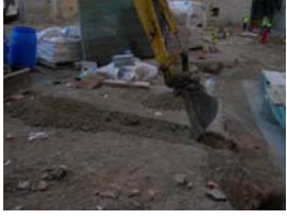
DSCN2023 Rebaix mecànic
