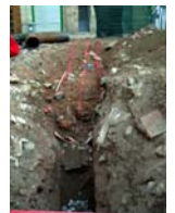
DSCN2035 Rasa connexió amb búnker
