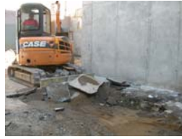
DSCN1463 Rebaix mecànic àmbit 6
