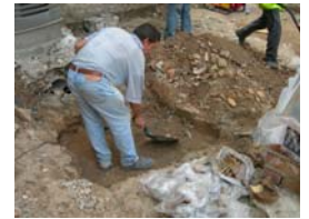
DSCN1506 Neteja manual dipòsit u.e. 2062
