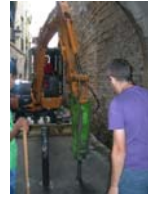
DSCN1334 Afectació mecànica de l'asfalt
