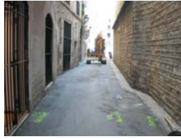
DSCN1311 Inici excavació
