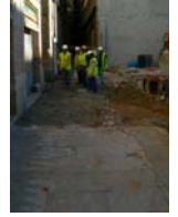
DSCN2181 Aixecament paviment
