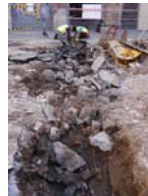
PIC02589 Afectació col·lector u.e. 2060
