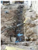
PIC02542 Afectació col·lector 2060
