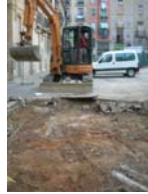
DSCN1380 Rebaix mecànic
