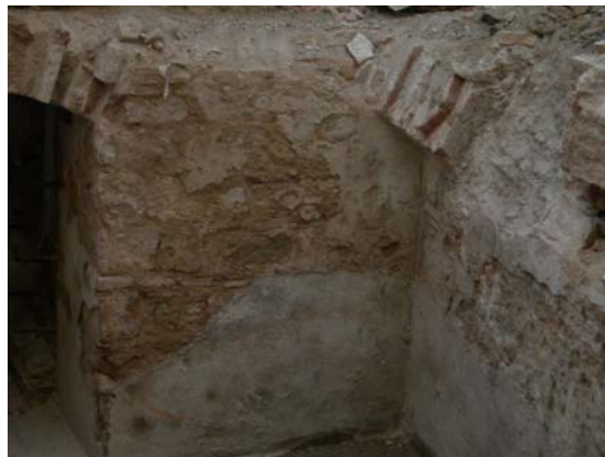
Imatges on s'aprecia les restes del soterrani amb la seva porta d'accés, el seu fons de ciment i les restes de la volta de maons
