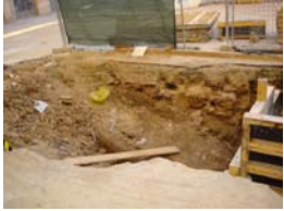
PIC02530 Construcció bunker
