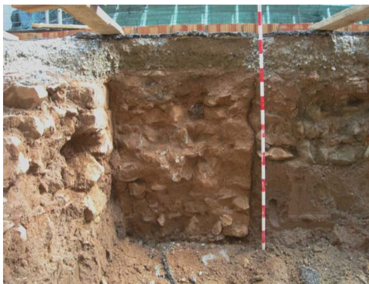
Vista de la estructura u.e. 1061
