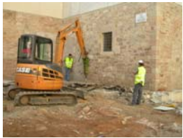
DSCN1462 Rebaix mecànic àmbit 6
