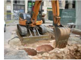
DSCN1629 procés d'afectació tenalles
