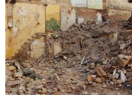
PIC02503 Demolició mecànica
