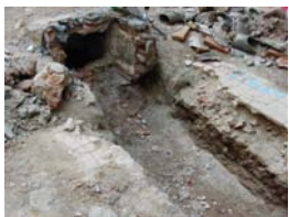
PIC02529 Afectació antics respiralls
