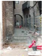
DSCN 1583 2 Tasques pavimentació
