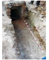
PIC02534 Afectació col·lector
