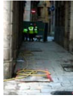
DSCN2098 Zona intervenció
