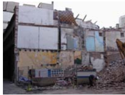
PIC02515 Final demolició
