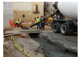
PIC02597 Afectació col·lector u.e. 2060
