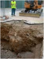
DSCN1308 Basament pilar u.e. 1006
