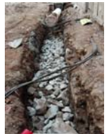
PIC02584 Afectació col·lector 2060
