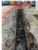
PIC02588 Afectació col·lector u.e. 2060
