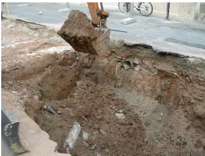
Inici del rebaix on s'observa l'estrat u.e. 1004
