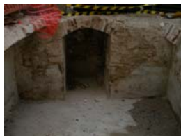
DSCN2018 Detall accés soterrani
