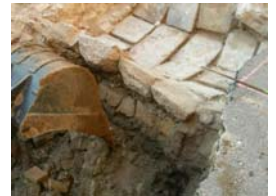
DSCN1648 Afectació dipòsit u.e. 1044
