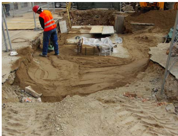
Procés de construcció de la estructura del bunker per la recollida pneumàtica
