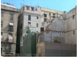
DSCN1591 Procés de demolició
