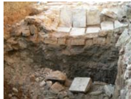
DSCN1651 Afectació dipòsit u.e. 1044
