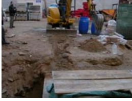
DSCN2024 Rebaix mecànic
