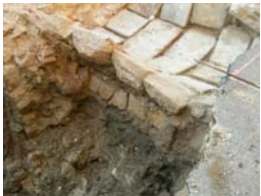
DSCN1649 Afectació dipòsit u.e. 1044
