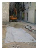
DSCN1562 Protecció restes amb geotextil
