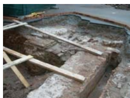
DSCN1343 Vista general sector ampliació búnker
