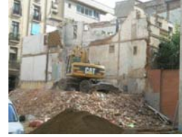
DSCN1727 Demolició mecànica
