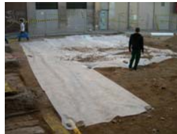
DSCN1579 protecció restes amb geotextil
