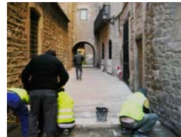
DSCN2034 Tasques pavimentació
