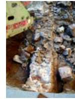
DSCN2192 Esc 6 Afectació estructures
