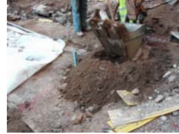
PIC02501 Afectació a Sector 2
