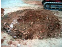
DSCN2141 Inici intervenció
