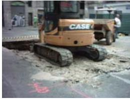
DSCN1252 Rebaix zona bunker
