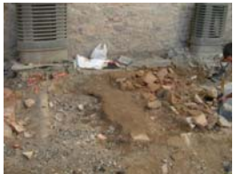
DSCN1585 Afectació paviment u.e. 2005
