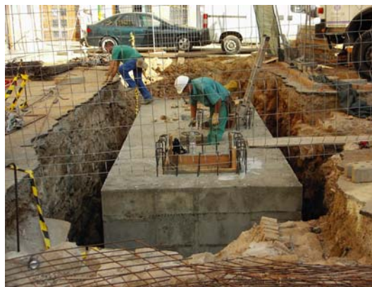
Procés de construcció de la estructura del bunker per la recollida pneumàtica
