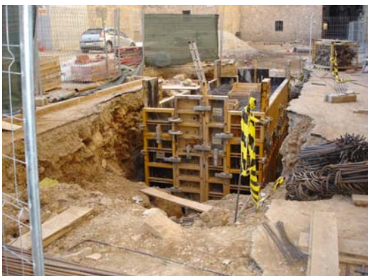
Procés de construcció de la estructura del bunker per la recollida pneumàtica
