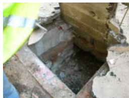
DSCN1396 Arqueta moderna de serveis
