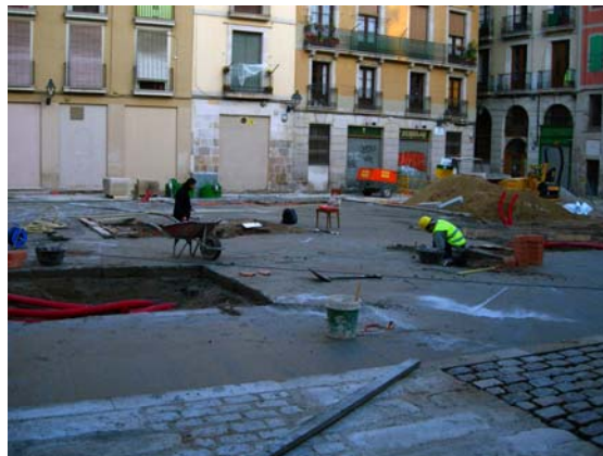
A l'esquerra vista del Sector 3 abans de la intervenció i de la deconstrucció de la finca i a la dreta durant la excavació dels escocells
