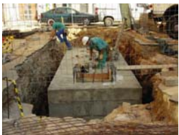
PIC02544 Construcció bunker
