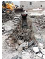
PIC02583 Afectació col·lector 2060
