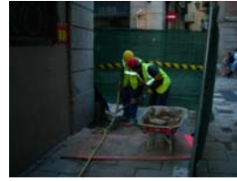
DSCN2099 Rebaix manual
