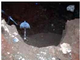
DSCN2068 Perfil Oest rasa connexió bunker
