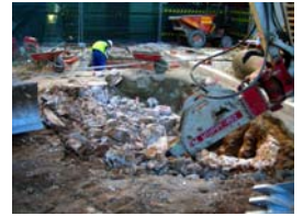
DSCN2193 Esc 6 Afectació estructures
