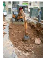
DSCN1639 procés afectació àmbit tenalles
