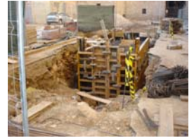
DSCN3184 Construcció bunker
