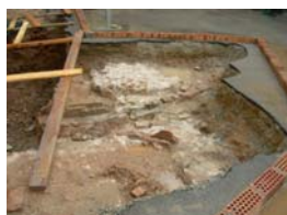
DSCN1332 Vista general sector ampliació búnker
