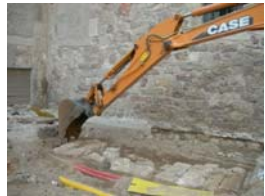
DSCN1611 Afectació tapa col·lector 2058
