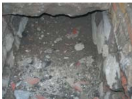
DSCN1395 Arqueta moderna de serveis
