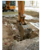
DSCN1615 Afectació arquetes modernes
