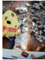
DSCN2191 Esc 6 Afectació estructures
