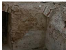
DSCN2019 Detall volta maons soterrani
