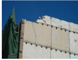
DSCN1465 Demolició manual
