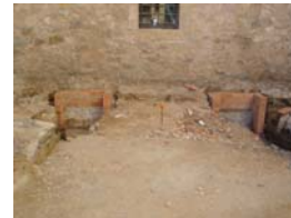
PIC02514 Construcció nous respiralls
