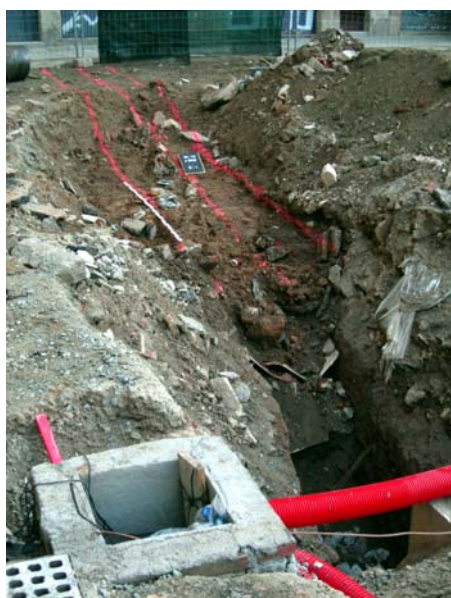
Vista de la rasa de connexió del bunker amb el carrer Flassaders
