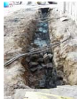
PIC02546 Afectació col·lector 2060
