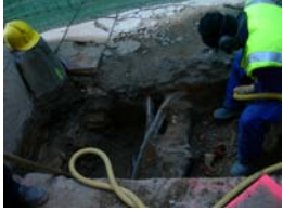
DSCN2115 Rebaix manual
