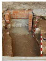
PIC02555 Construcció nou respirall
