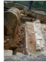
DSCN1642 Afectació estructures
