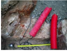
DSCN2091 Esc 3 Detall dipòsit u.e. 3005
