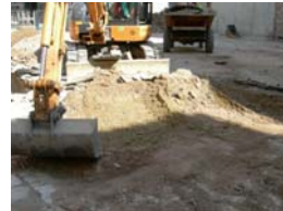
DSCN1413 Afectació u.e. 2004
