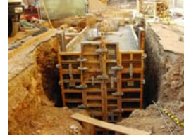
PIC02533 Construcció bunker
