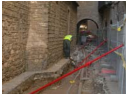
DSCN1495 Protecció rasa
