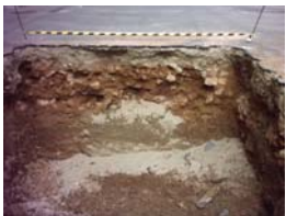
DSCN1261 Vista perfil Nord bunker
