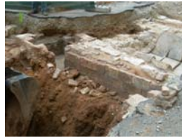
DSCN1641 Afectació estructures
